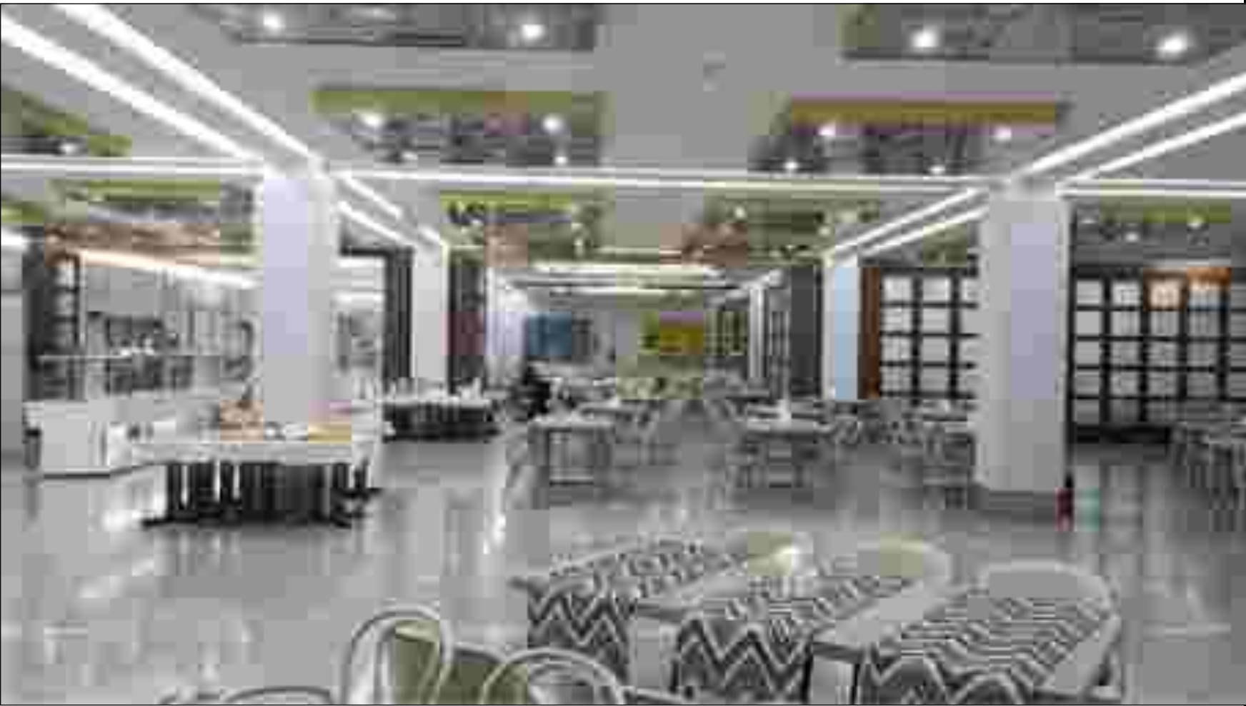
Фото потолка зала
